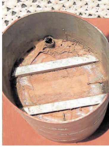
ಮಳೆನೀರಿನ ಮೇಲುಬಾವಿ ಪ್ರತ್ಯೇಕಿಸಲು ಸ್ಲಾಬ್ ತಯಾರಿಯ ಮೊದಲು ಅದರ ಅಡಿಭಾಗದಲ್ಲಿ ಸಮಾಂತರವಾಗಿ ಸಿಕ್ಕಿಸಿರುವ 'I' ಸೆಕ್ಷನ್ ತೊಲೆಗಳು
