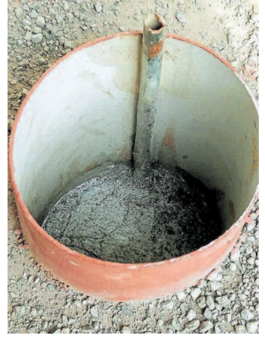
ಉದಯ ಪೋಸ್ಟರ್ ಅವರ ಮನೆಯಂಗಳದ ಬಾವಿಯ ಪ್ರತಿಕ್ರಮ. ಪಂಪಿನ ಸ್ಪ್ಲಿನ್ ಪೈಪ್ ಇಳಿಸಲು ಕೊಳವೆಬಾವಿಯ ಕೇಸಿಂಗ್ ಪೈಪ್ ಜೋಡಣೆ.
